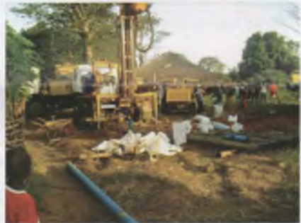
Bau eines Bohrbrunnens in Djaubecuta
