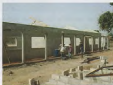
Eine Schule im Bau
